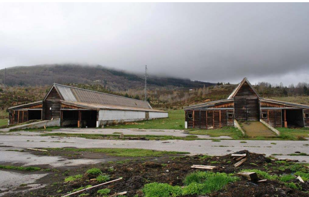
Kalinovik – původní ovčiny, které budou zbourány a na jejichž místě by měly vyrůst nové stáje
